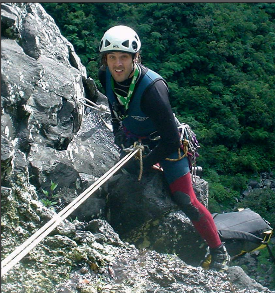
► Montando el pasamanos de acceso a la tirada de 96 metros. (Foto: Luis L. Magaña)
