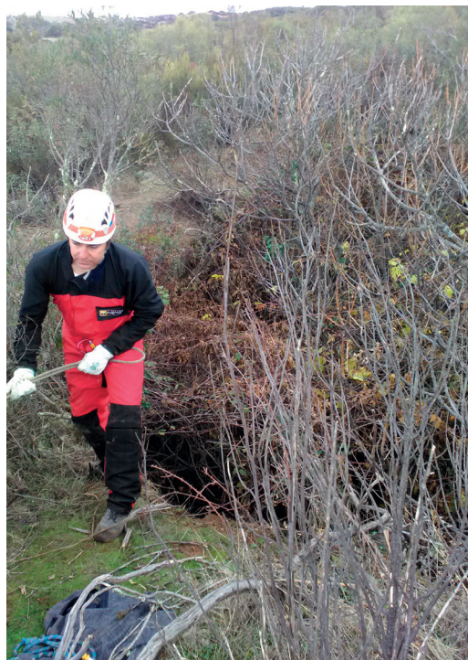
Vista del hundimiento desde el exterior.
