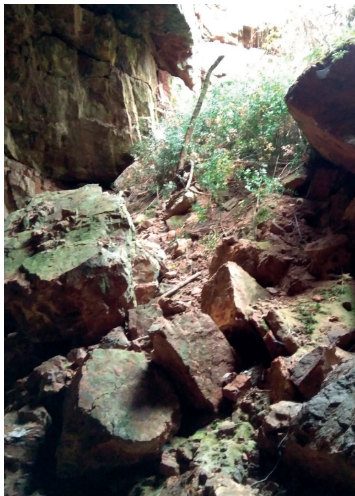
Evidencias del derrumbe de los techos.
