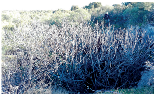
Vista del hundimiento desde el exterior.
