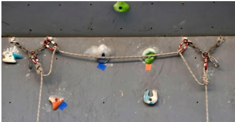
Ilustración 12. Montaje de pasamanos en rocódromo
