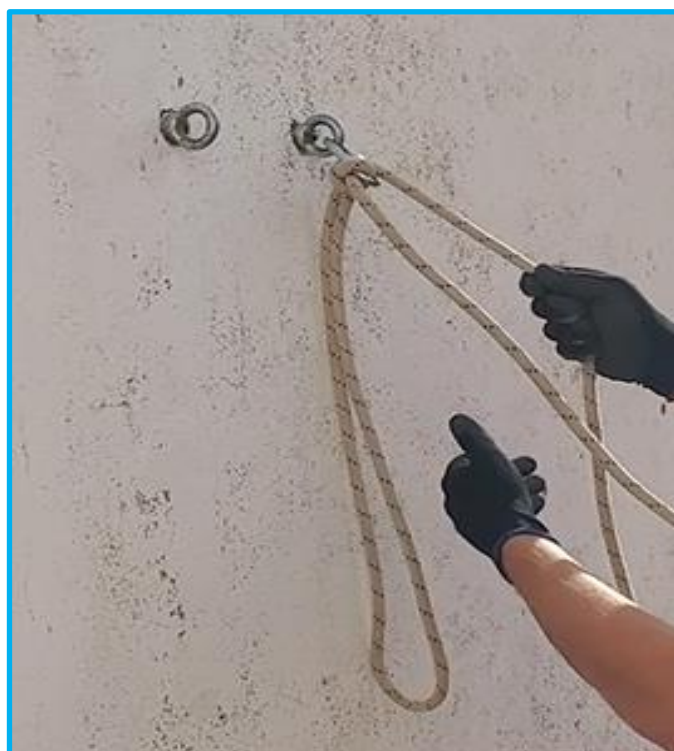
Ilustración 25. Gaza azocada contra el anclaje del desviador
