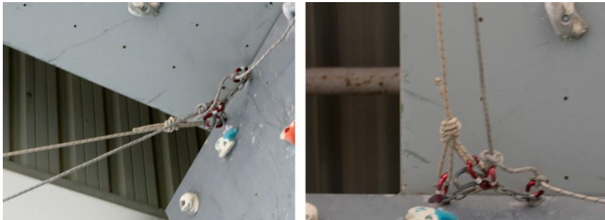
Ilustración 18. Montaje tirolinas
