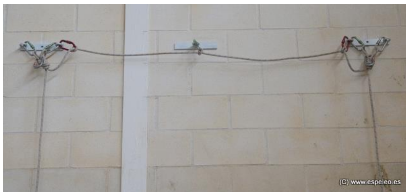
Ilustración 13. Montaje de pasamanos en espeleódromo
