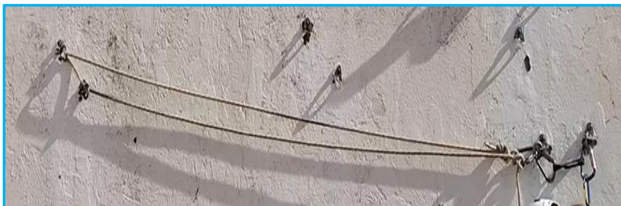
Ilustración 27. Montaje completo del pasamanos sin punto intermedio
