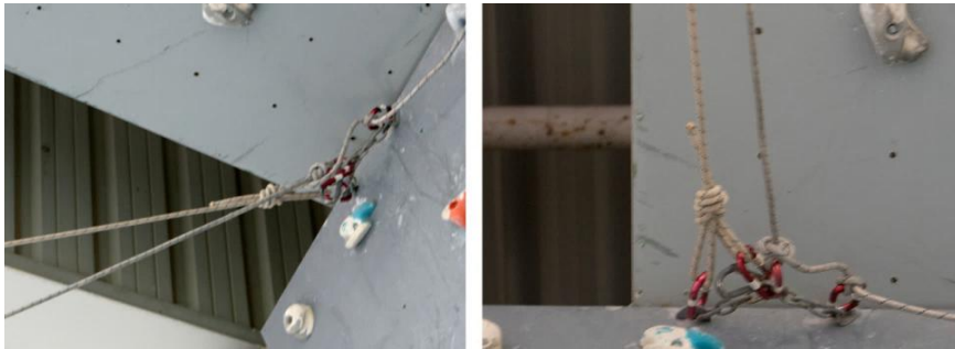
Ilustración 18. Montaje tirolinas
