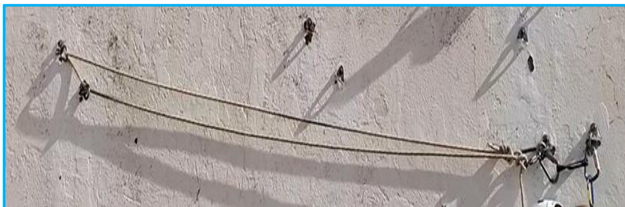
Ilustración 28. Montaje completo del pasamanos sin punto intermedio
