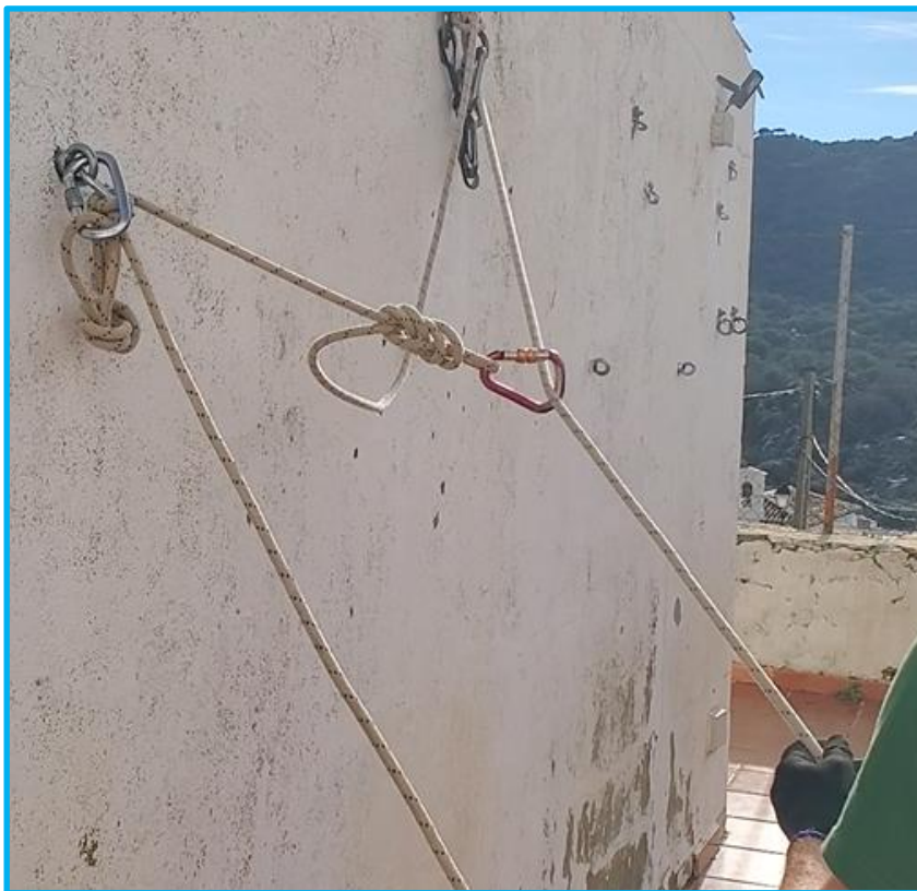
Ilustración 27. Montaje completo del desviador
